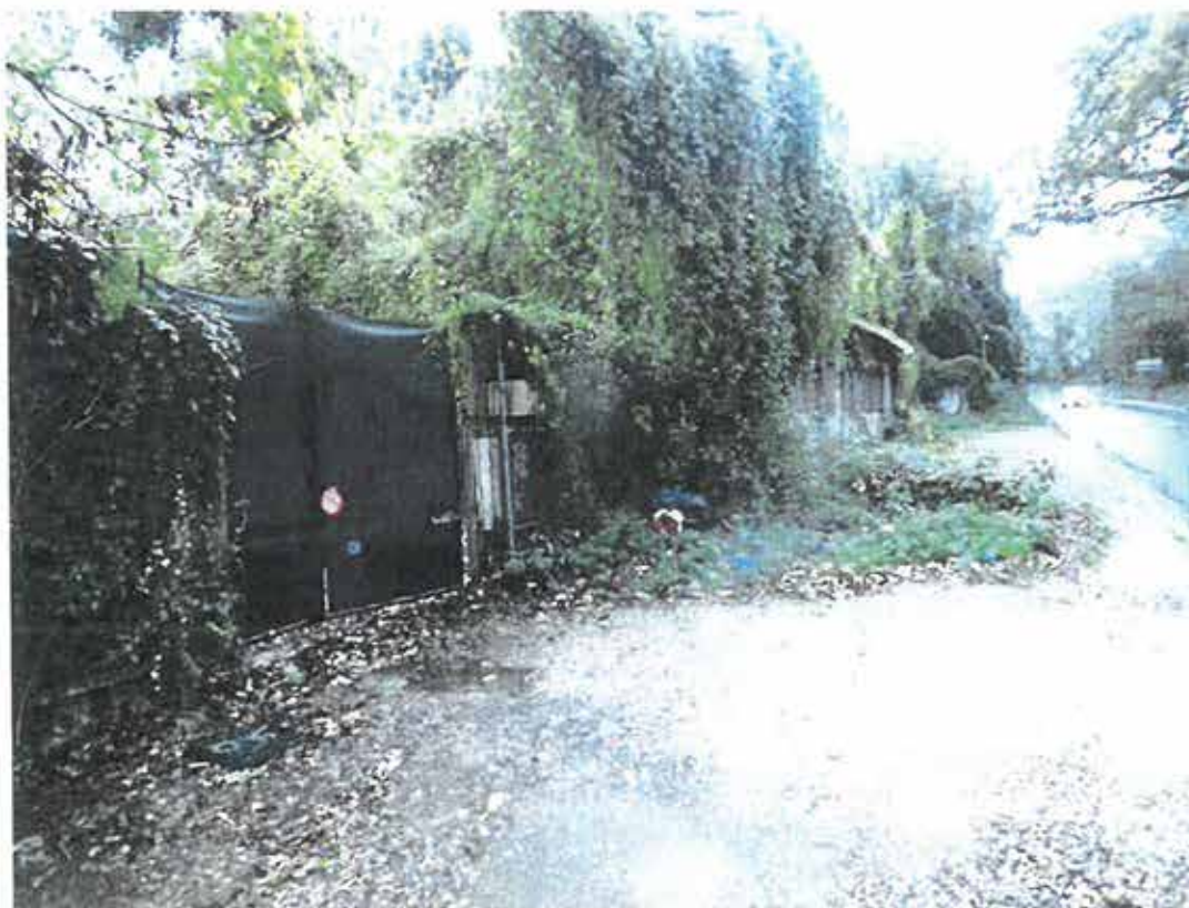
PORTAIL SUR L'AVENUE DE DOMONT
