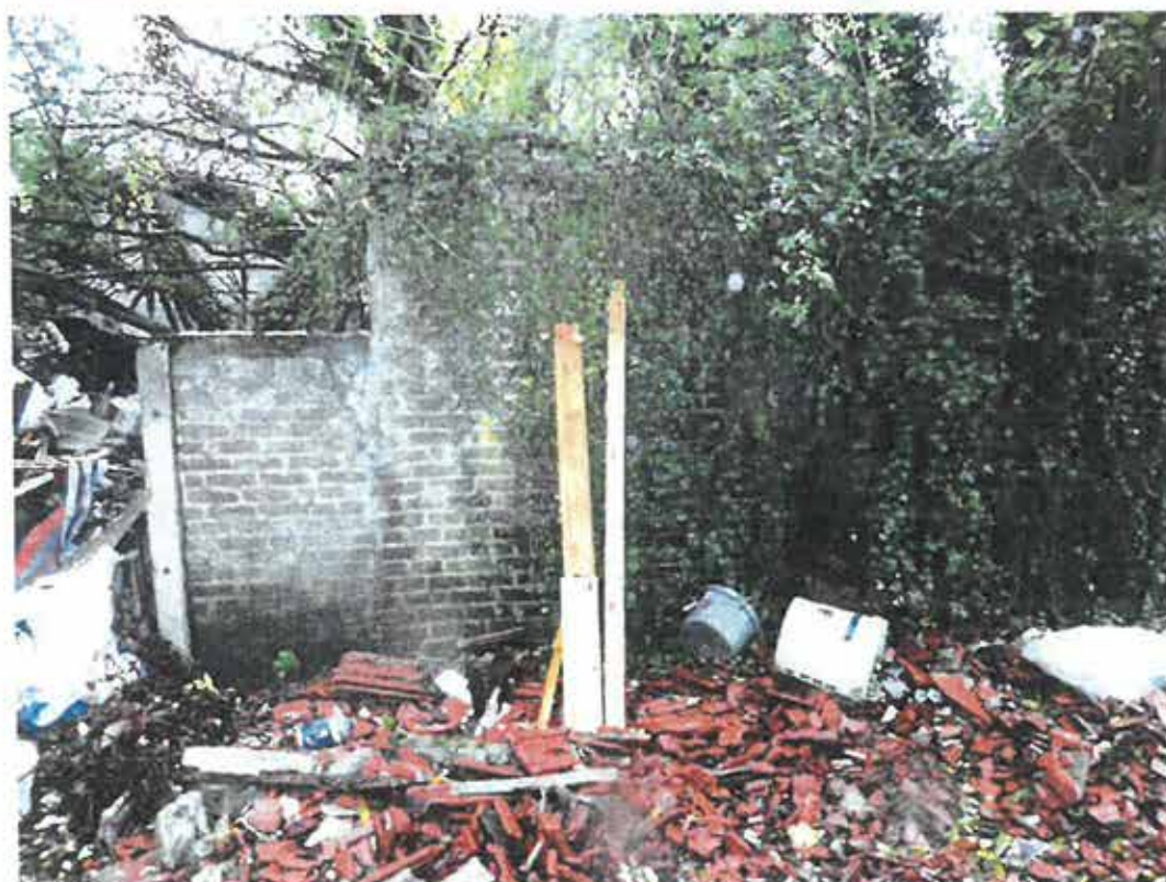
BATIMENT D UNE SURFACE DE 150M2 EN BRIQUES COUVERTURE EN TUILES MECANIQUES MAUVAIS ETAT
