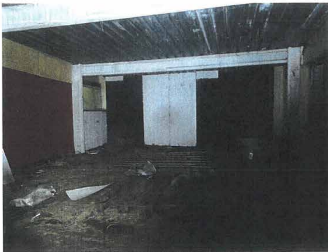
9- CHALET EN BOIS D UNE SURFACE DE 320 M2
