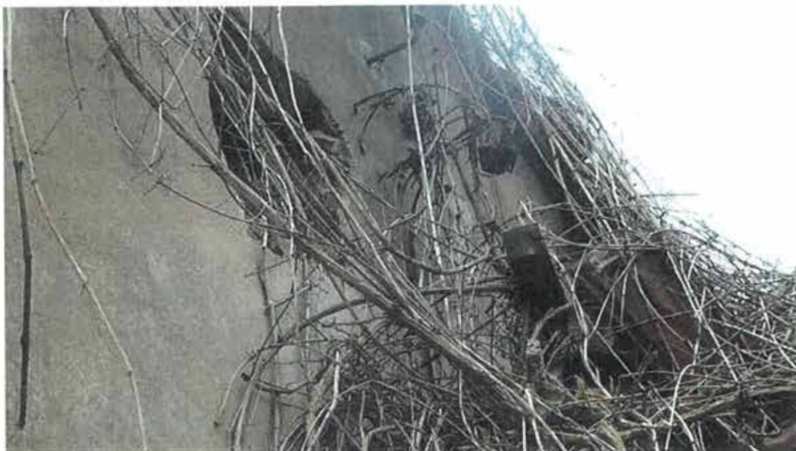
Alimentation électrique aérienne
